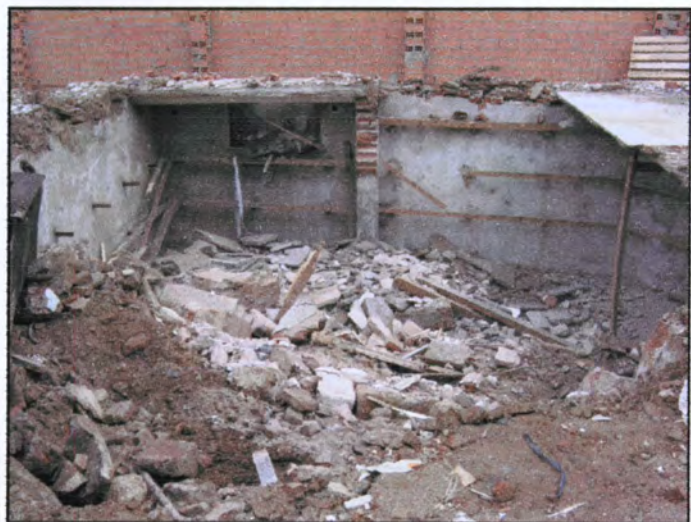
Procés d'obertura del sostre del soterrani
