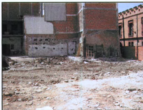
Vista general del solar de Cal Miernau
